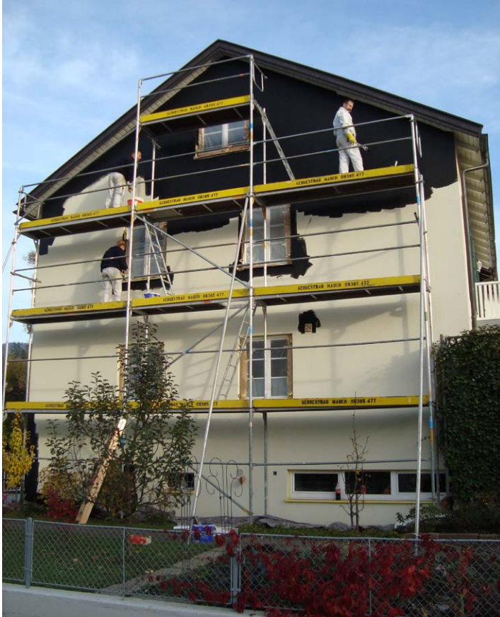
▲ Das Haus wird mit einer dunklen grafithaltigen Abschirmfarbe gestrichen. Diese Farbe wird danach wieder mit einer hellen Farbe überstrichen.
