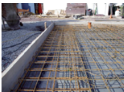
Abb. 1: Baustahlgitter vor dem Betonieren
